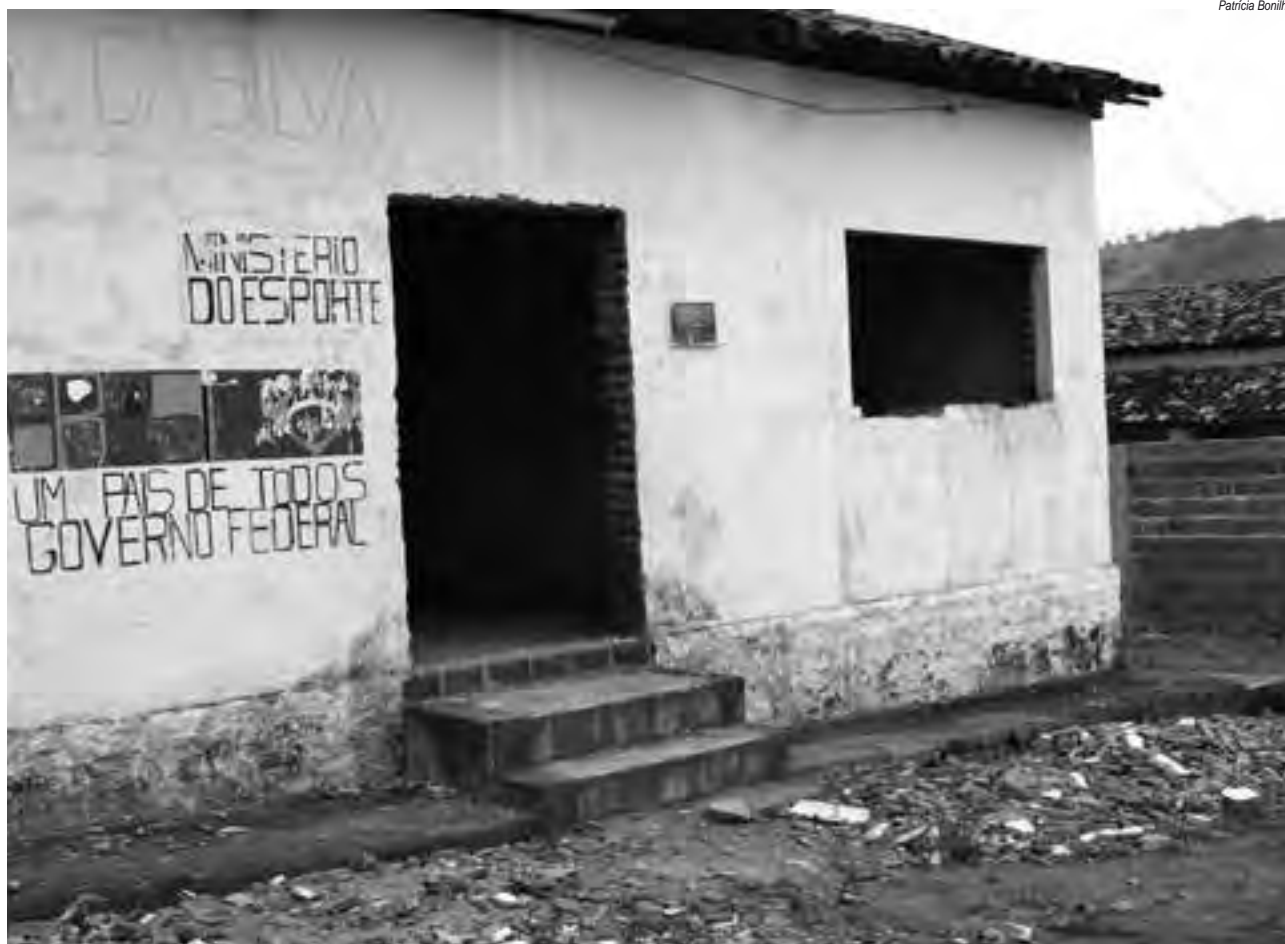
Somente após a ocupação da secretaria de educação de Alagoas, pelo povo Xukuru-Kariri, foi concluída a reforma do prédio escolar; três anos depois do início das obras
